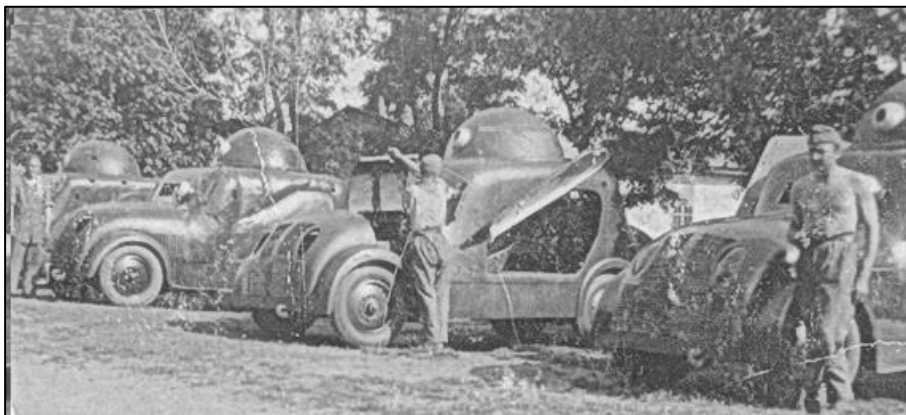
2. kép. Az Uhry járműgyár által – a valódi páncélozott eszközök hiánya miatt – FIAT 2F alvázra épült lemezborítású „atrapa” páncélgépkocsik, melyek a csehszlovák Prága II Béka típusú páncélgépkocsik utánezata volt
